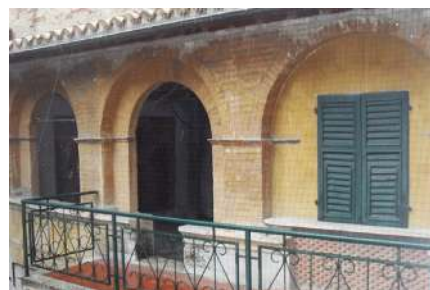
Rete installata su un balcone
