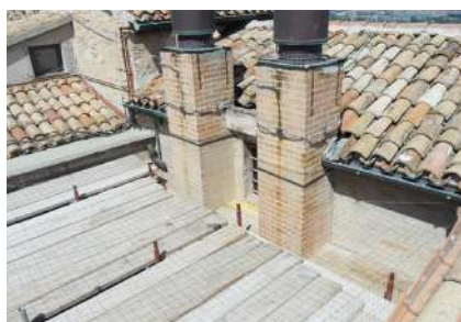
Rete installata su un cortile
