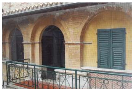
Rete installata su un balcone
